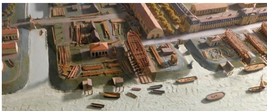
La última grada de construcción del arsenal de Rochefort, ocupada por la Flore a partir de 1847. Plano en relieve diseñado en los años 1840 por Jean-Marie Touboulic, ingeniero de la Marina. Museo Hèbre, Rochefort.
