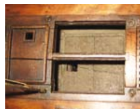
Grandes écouteilles. Celle du second pont est à deux volées de caillebotis, avec une entretoise centrale amovible. Celle du premier pont est fermée par deux grands panneaux, avec un écouillon pour l'ancre de miséricorde. Sur la gauche, apparaît l'ouverture pour l'évacuation des fumées du four à pain et le cadre pour l'eau de refroidissement du pont, en cas de besoin.
