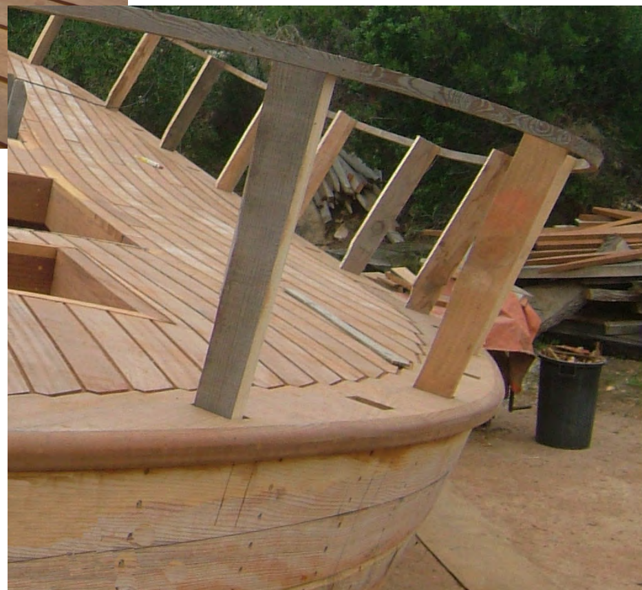
Foto n° 77a - Un’imbarcazione reale: da essa possiamo vedere effettivamente come venivano realizzati i fori per l’inserimento degli scalmotti.
